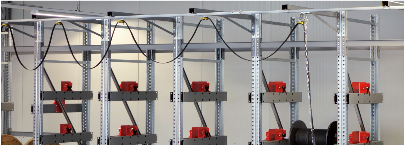
Abb. 17 Kabelwagensystem für die Regalmontage
